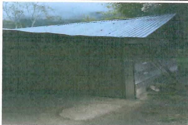
Foto 1: MEJORAMIENTO DE COCINA
