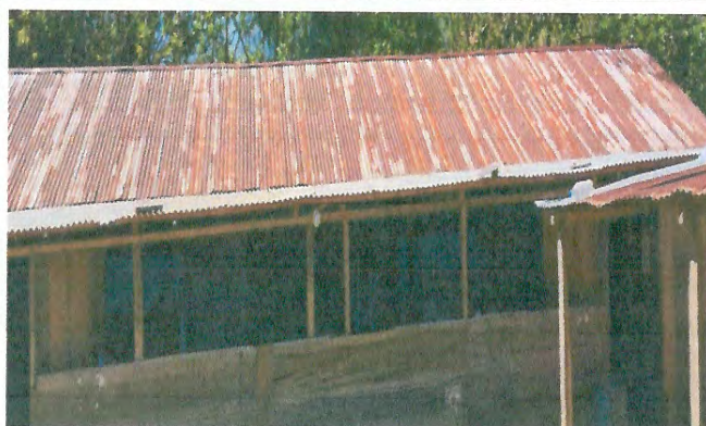
Foto 1: CUBIERTA DE LAMINA
